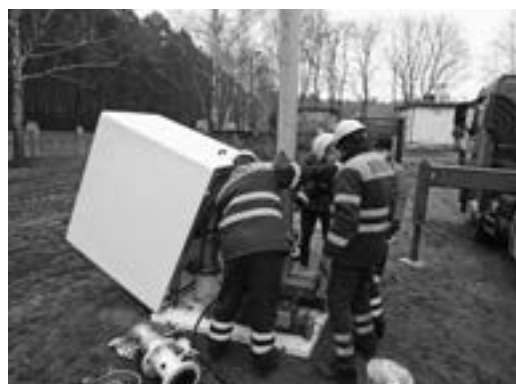
il. 12 Montaż pompy głębinowej w nowej studni na terenie SW1 (źródło: Muzeum Wodociągów w Bydgoszczy, fot. Bartłomiej Bromberek)
