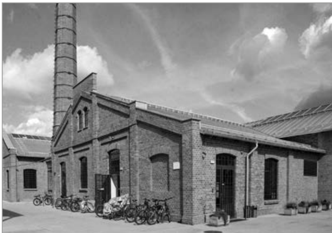
il. 5 Fragment budynku kuźni, stolarni i kotłowni z zachowanym kominem, po remoncie, fot. Jakub Jastrzębski, 2021
