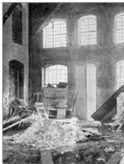
il. 2 Zdjęcie wnętrza hali odlewni przy ulicy Krowoderskiej 31 przed przebudową w 1902 roku (źródło: „Ilustracja Polska” 1902, R. 2, nr 15)
