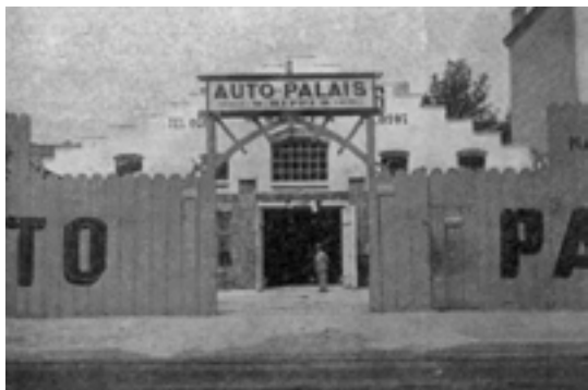
il. 2 Zabudowania Auto-Palais W. Rippera widoczne od ulicy Smoleńsk. Za bramą wjazdową widoczny jest budynek przebudowany na halę garażową, 1912
