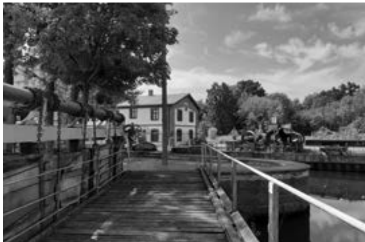
il. 10 Lubicz Dolny, jaz piętrzący na Drwęcy, mechanizm zamykający upustu jałowego, widok w kierunku południowym, w tle kantor (obecny budynek biurowy), fot. Karolina Mrowińska, lipiec 2020
