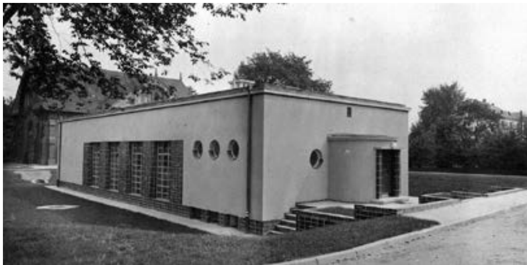
il. 2 Nowa hala pomp na terenie stacji wodociągowej Las Gdański, 1937. (źródło: Muzeum Wodociągów w Bydgoszczy)
