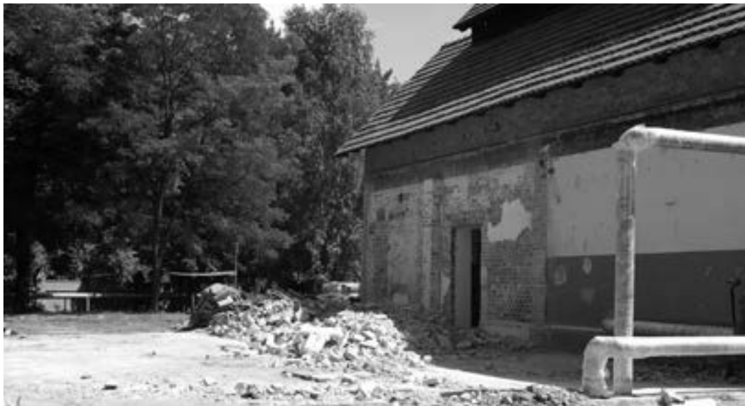
il. 3 Rozbiórka przybudówek przy dawnym budynku gazogeneratorów w celu budowy zaplecza socjalnego Muzeum Wodociągów, 2011 (źródło: Muzeum Wodociągów w Bydgoszczy)
