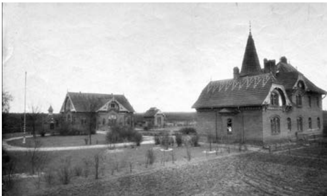
il. 1 Stacja wodociągowa „Las Gdański” w Bydgoszczy na początku XX wieku. Patrząc od lewej strony, widoczna jest wieżyczka studni zbiorczej, następnie hala pomp, gazogeneratorownia i budynek mieszkalny – „Pałacyk” wraz z ogrodem (źródło: Muzeum Okręgowe im. Leona Wyczółkowskiego w Bydgoszczy, sygnatura MOB_HF_1639)
