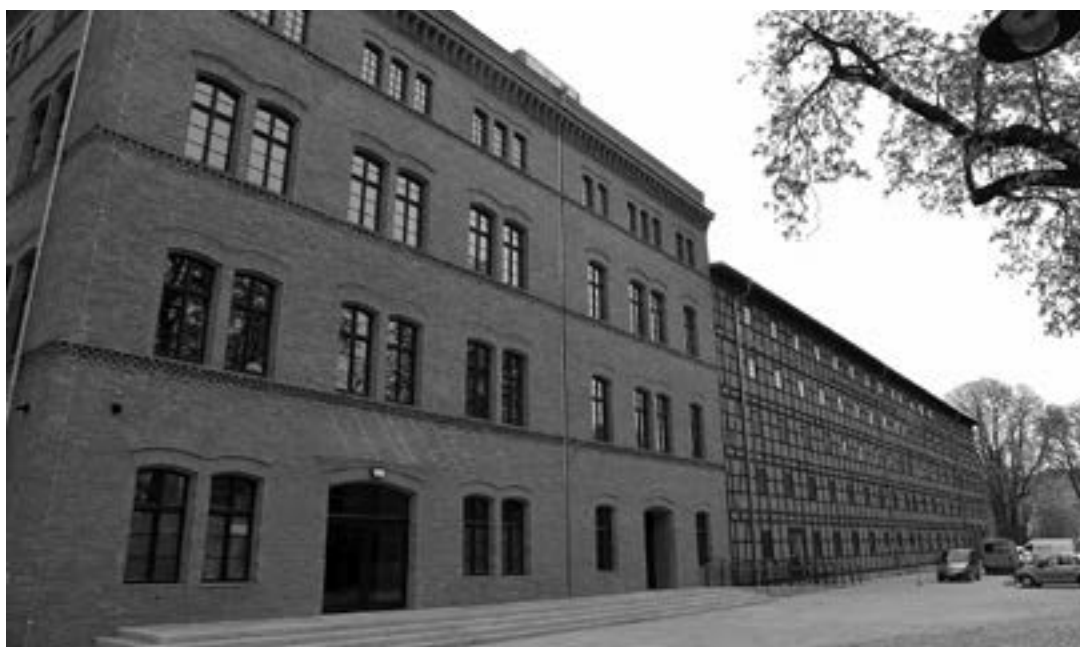
il. 2 Elewacja południowo-wschodnia Młyna Rothera, fot. Robert Sawicki, Park Kultury w Bydgoszczy
