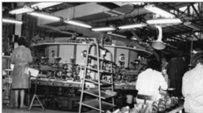
il. 7 Nalewarka spodów obuwia firmy GUSBI w Fabryce Obuwia numer 3 w Solcu Kujawskim, lata osiemdziesiąte (źródło: zbiory Muzeum Solca im. Księcia Przemysła, numer inwentarzowy MS/H/F/646)
