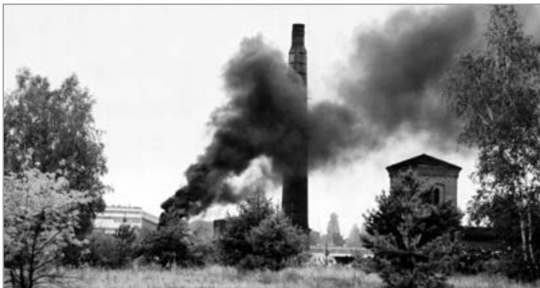
il. 10 Dymy pożaru trawiącego ruiny budynków Nasycalni, wrzesień 2006 roku, fot. Jadwiga Bretes
