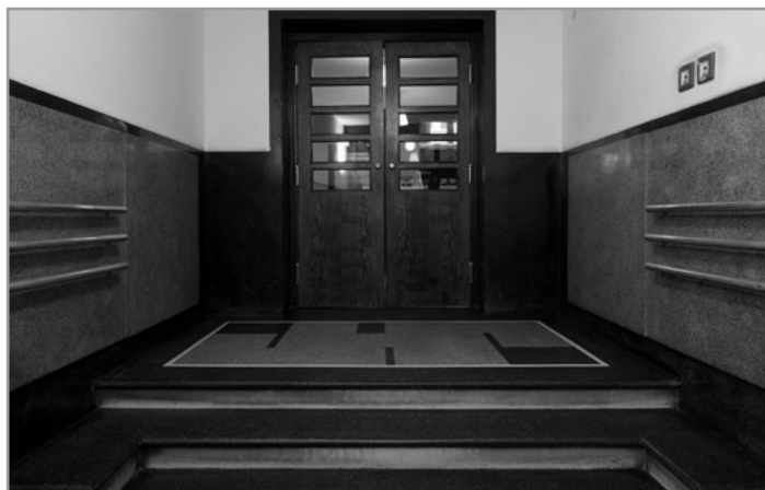
il. 7. Sień kamienicy przy ul. Abrahama 28, z pierwotnego wystroju: partie ścian oraz posadzka i stopnie wykonane z lastryka, metalowe pochwyty na ścianach, stolarka drzwiowa; wnętrze po kompleksowych pracach konserwatorskich, fot. Bartłomiej Ponikiewski
