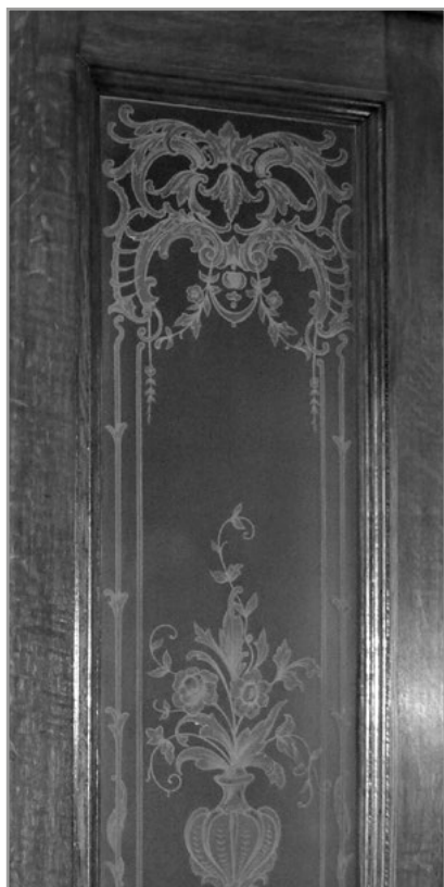
il. 7. Górna część dekoracji szyby nieprzeziernej, trawionej wielotonowo, fot. Małgorzata Maksymiuk
