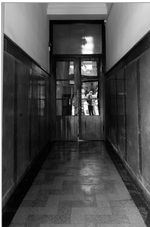
il. 5. Sień w kamienicy przy ul. Świętojańskiej 18, z pierwotnego wystroju: ściany wykończone szlifowaną twardą wyprawą z masy cementowej, płyty z lastryka na posadzce, stolarka drzwiowa, fot. Biuro Miejskiego Konserwatora Zabytków w Gdyni
