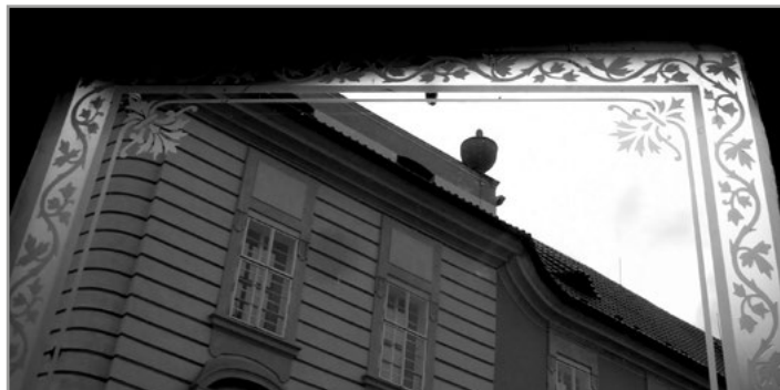
il. 3. Przezierna szyba trawiona dwutonowo, fot. Małgorzata Maksymiuk
