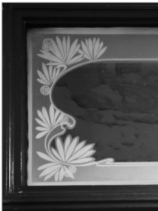
il. 2. Dwutonowe szkło trawione w nadświetlu drzwi wahadłowych z kamienicy przy ul. Łobzowskiej 3, fot. Jakub Jastrzębski, 2022
