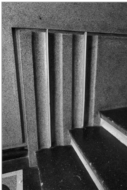
il. 9. Historyczny detal w sieni w kamienicy przy ul. Świętojańskiej 122, wykończenie z lastryka urozmaicone pionowymi listwami z jasnego materiału, fot. Biuro Miejskiego Konserwatora Zabytków w Gdyni
