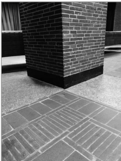
il. 10. Fragment posadzki i filara w pomieszczeniu garderoby, Fot. autor, archiwum własne
