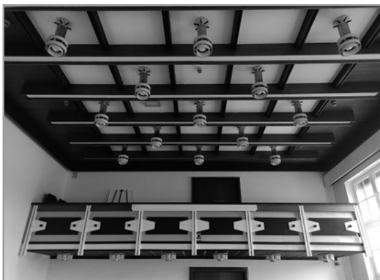
il. 6. Zdjęcie fragmentu sufitu podwieszanego oraz antresoli Miejskiego Ośrodka Sztuki w Gorzowie Wielkopolskim, archiwum własne
