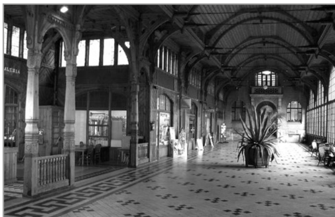
il. 3. Wnętrze hali spacerowej w Świeradowie-Zdroju, fot. dolny-śląsk.org.pl
