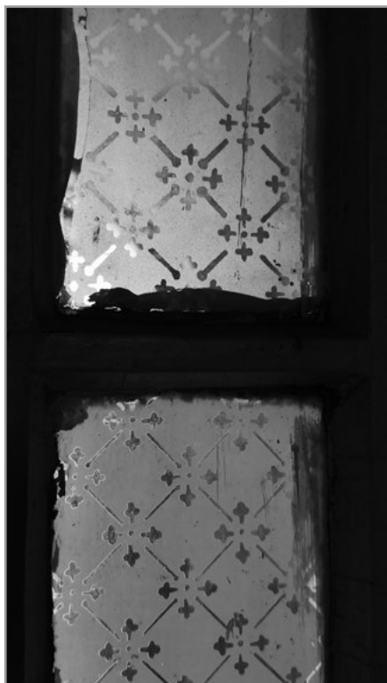
il. 1. Szyby muślinowe w jednym oszkleniu: trawiona (u góry) i matowiona farbami emaliowymi (później wypalnymi), fot. Małgorzata Maksymiuk
