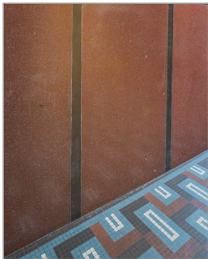
il. 6. Sień w kamienicy przy ul. 10 Lutego 5, z pierwotnego wystroju: ściany wykończone szlifowaną twardą wyprawą z masy cementowej, posadzka z płytek kwadratowych tzw. irysków, fot. Biuro Miejskiego Konserwatora Zabytków w Gdyni
