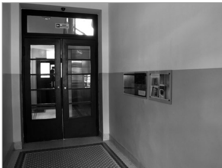
il. 4. Sień w kamienicy przy ul. Starowiejskiej 7/Abrahama 2, z pierwotnego wystroju: posadzka z płytek, tzw. gorsecików, stolarka drzwiowa, współczesne modyfikacje: ściany po współczesnym remoncie z zachowanym i wyeksponowanym historycznym fragmentem wykończenia, fot. Robert Hirsch
