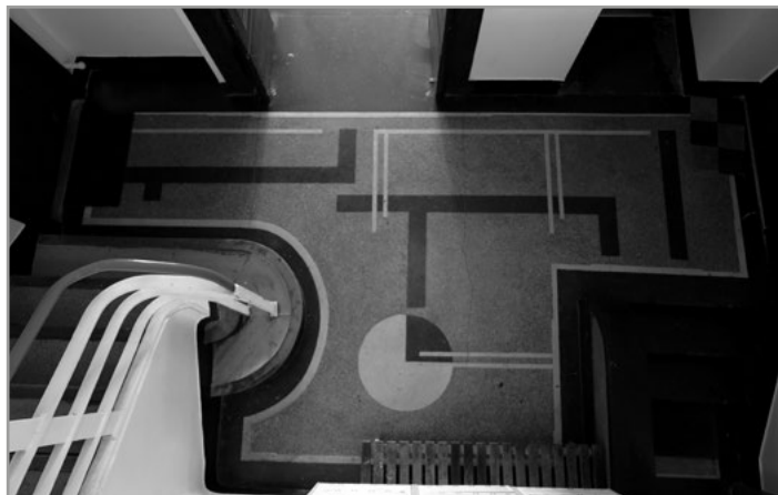
il. 8. Wnętrze klatki schodowej w kamienicy przy ul. Świętojańskiej 122; z pierwotnego wystroju: lastrykowa posadzka, fragment schodów z oryginalnym połączeniem drewnianej listwy oraz wykładziny z miękkiego tworzywa, współczesne modyfikacje: podwyższona historyczna balustrada schodów i wymieniony pochwyt, fot. Biuro Miejskiego Konserwatora Zabytków w Gdyni
