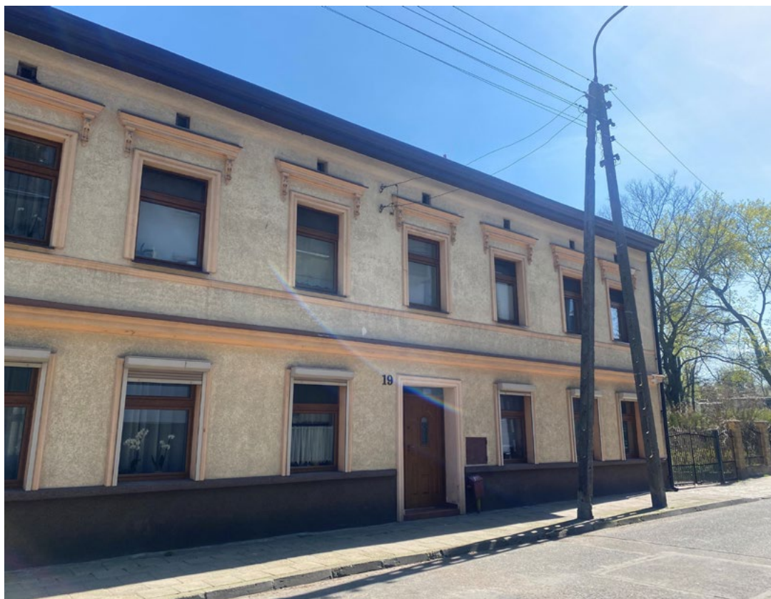
Ulica Staroszkolna 19 w Bydgoszczy, front kamienicy, fot. Sandra Hetzig
