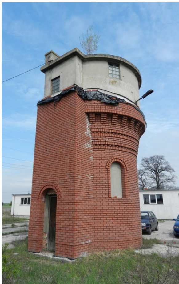
Wieża ciśnieniowa przy ulicy Leśnej w Lipnie, fot. Kamil Szymański
